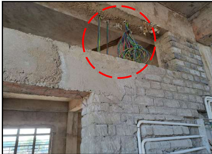
Improper Conduit laying
