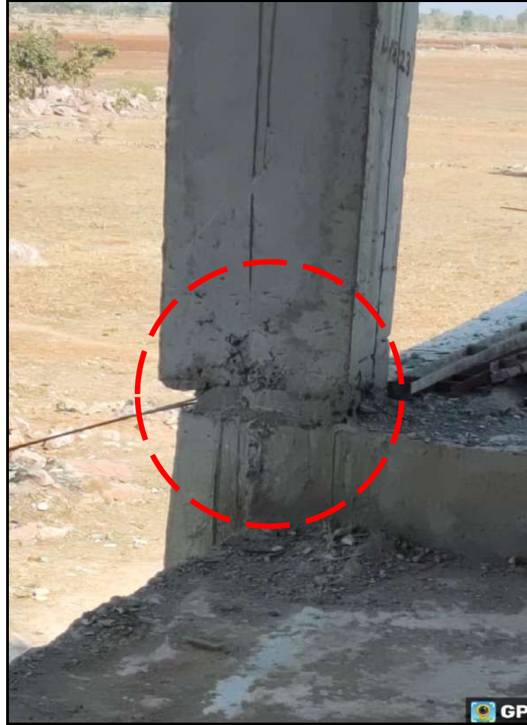
Overhung & eccentric columns
